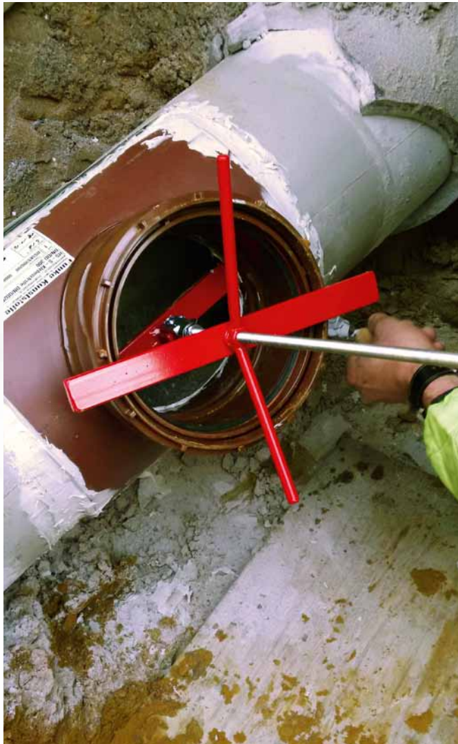
Selle de piquage à coller HSK fixée à l'aide de la clé de serrage
