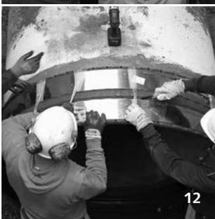
Beim Herablassen ist darauf zu achten, dass die VPC®-Rohrkupplung XXL keinen ruckartigen Bewegungen ausgesetzt wird. Es darf keine Pendelbewegung entstehen **(6)**!
