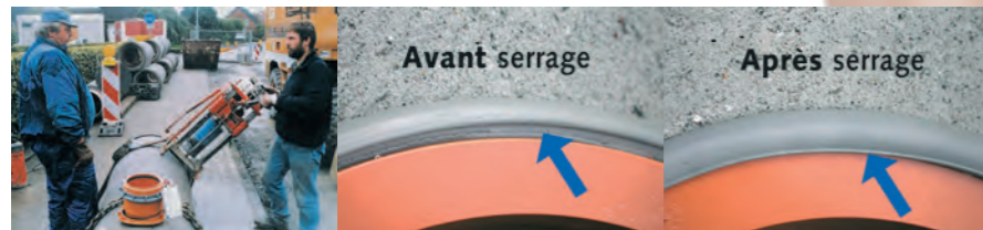
Positionnement correct de la carotteuse.
