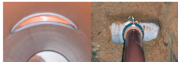
Positionnement correct de la pièce de piquage à l'intérieur d'une canalisation FABEKUN®.
