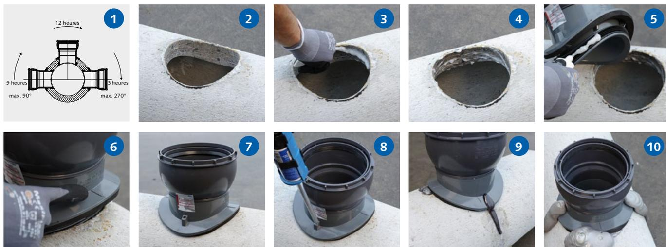
Le carottage doit être réalisé de manière centrée par rapport à l'axe du tube, avec un angle de 90°. Le fabricant recommande de percer les tubes à fond plat à 9, 12 ou 3 heures et les tubes circulaires entre 9 et 3 heures. (1)
