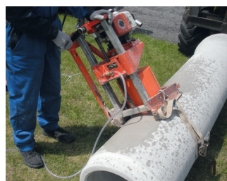
Becon Anschluss nie unterhalb des Kämpfers einbauen Ne jamais installer le raccord Becon sous le battant
