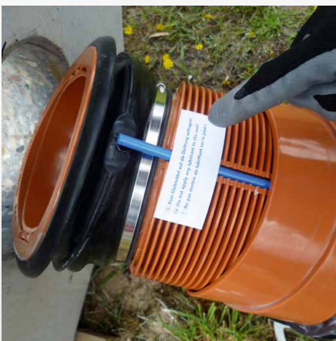
Mesure depuis le sommet de la conduite jusqu'au bord supérieur du carottage (voir tableau)
