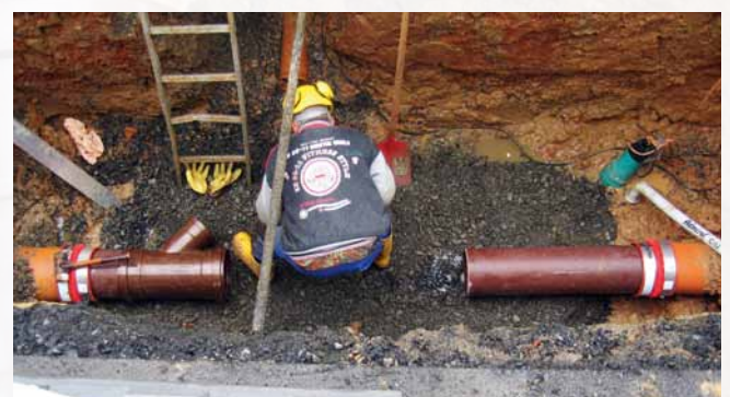
Defecte buizen repareren
