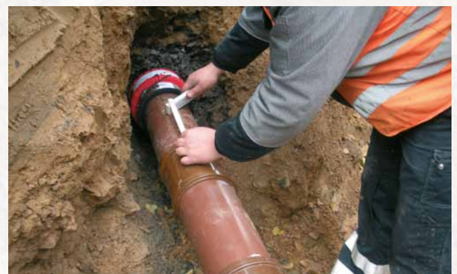
Defecte buizen repareren
