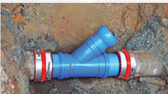
Een aftakking met een bestaande gresbuis verbinden
