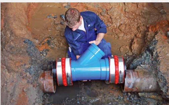
Een aftakking met een bestaande gresbuis verbinden
